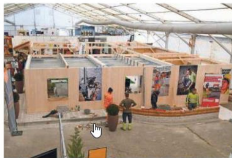
Dans le pavillon des bâtisseurs, une villa se construit de A à Z sous les yeux des visiteurs.
